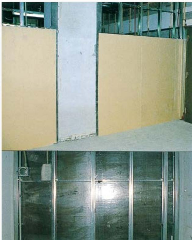
レイプロット鉛ボードは、不燃性材料の石膏ボードに鉛板を貼り合わせたもので、放射線透過を遮蔽する放射線防護鉛ボードです。
