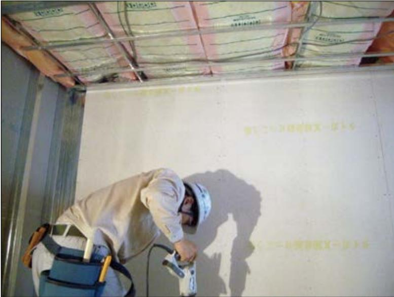
レイプロット鉛フリーボード・Homeは『“鉛”を使用しない放射線透過防護材。地球環境に配慮した“環境にやさしい建材”』の『レイプロット鉛フリーボード』を軽量さや環境に優しいという特長を活かして、一般の家屋などにも使用できるようにした放射線透過防護材として発売しております。シックハウス症候群の一因であるホルムアルデヒド放散量は0.1mg/l未満のF★★★★適合品で、安心して使用できます。
