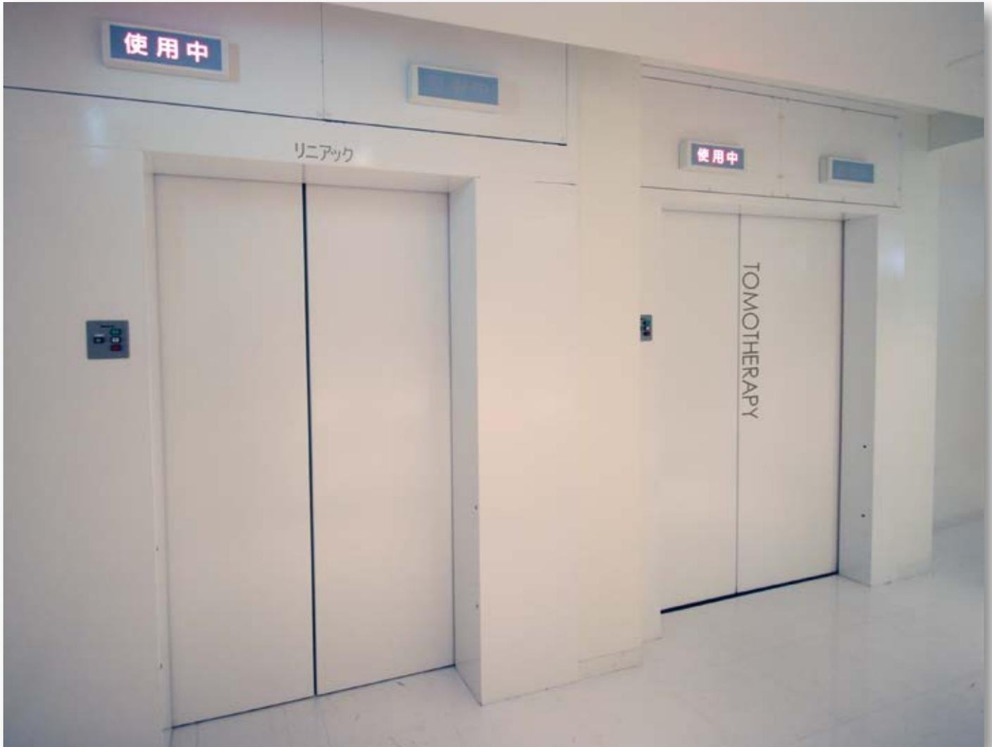
近年、医用加速器による高エネルギー放射線を用いた強度変調放射線治療 (IMRT) や定位放射線治療が普及してきており、リニアックなど高エネルギー装置の導入、設置は年々増加してきています。一方、これら使用施設の放射線防護を安全で経済的にするための新しい防護材へのニーズは高まってきています。レイ・プロット中性子ドアは、リニアック治療室の照射室用の防護扉で、ドア内部に挿入してあるボロン入り超高分子量ポリエチレンと鉛板により中性子およびX線を遮蔽します。
