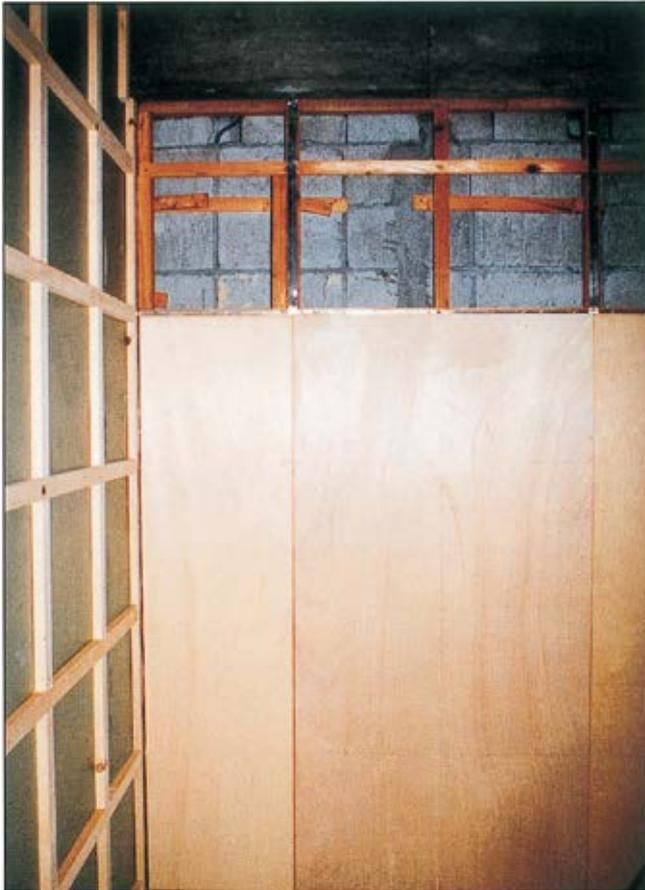
レイプロット片サンド鉛合板は、耐水ベニヤと放射線を効果的に防ぐ鉛板との二重構造になっており、放射線透過を遮蔽する放射線防護鉛合板です。
