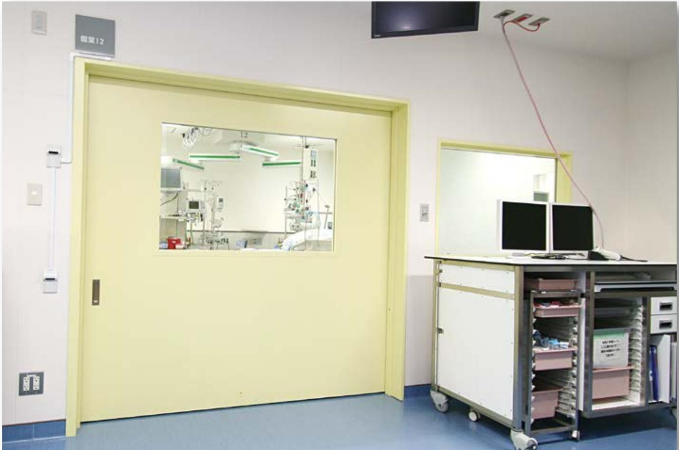
レイプロット・ハンガードアは放射線の透過遮蔽とX線室の有効利用を考慮した、放射線防護ハンガードアです。自閉装置付なので閉忘れがなく、全開時ストップ装置によりストレッチャー等も容易に通過できます。
